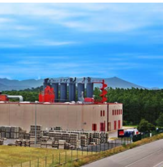
Sede da Aco Iberia em Maçanet de la Selva
