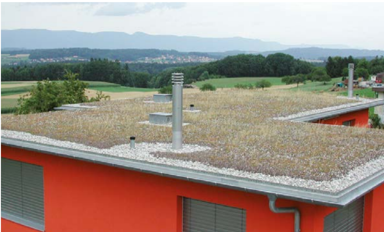
Ajardinamiento extensivo de cubierta Ajardinamento extensivo de cobertura
