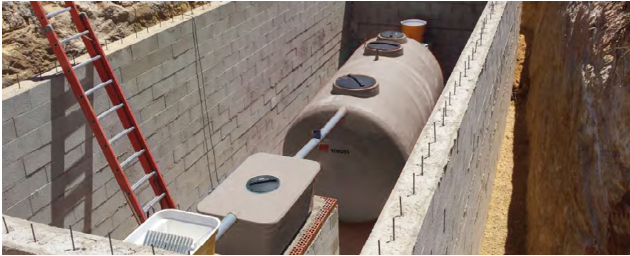
Instalación depuradora perfil hidráulico Instalação de depuradora de perfil hidráulico
