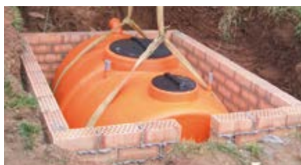
NECOR 5 vivienda unifamiliar
