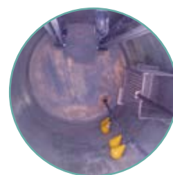
pozos de bombeo
