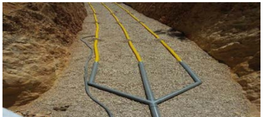
Tubos de drenaje sobre grava en zanjas
