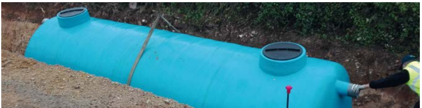
Instalación depósito DRP
