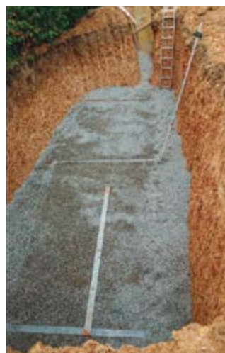
DEPÓSITO DE RECOLHA DE ÁGUAS PLUVIAIS HORIZONTAL ENTERRADO DE 35.000 l
