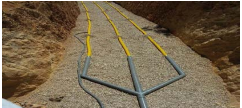
Tubos de drenagem sobre gralilha em valas
