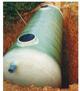
DEPÓSITO DE RECOLHA DE ÁGUAS PLUVIAIS HORIZONTAL ENTERRADO DE 35.000 l
