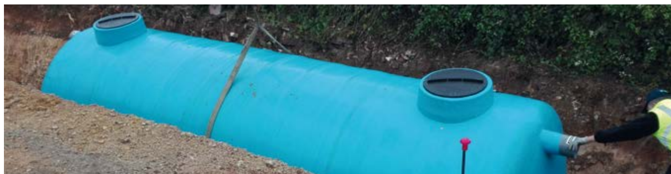
Instalação de depósito DRP
