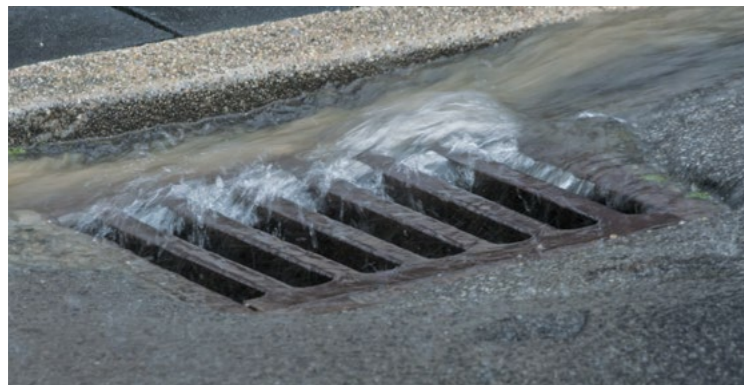
Rebosamiento de agua en sumidero de carretera durante una lluvia torrencial
