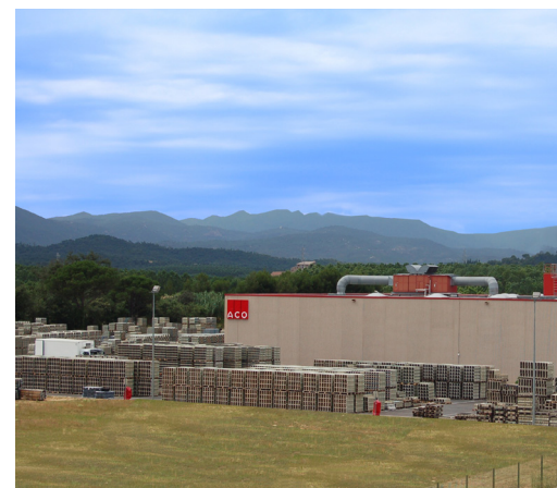
Sede ACO Iberia Maçanet de la Selva, Girona, Espanha
