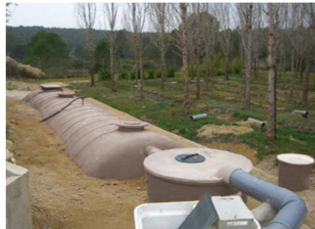
Instalación depuradora perfil hidráulico Instalação de depuradora de perfil hidráulico
