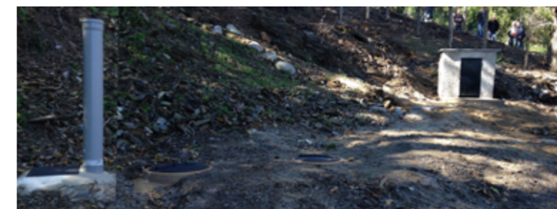
NECOR 75 población aislada povoação isolada
