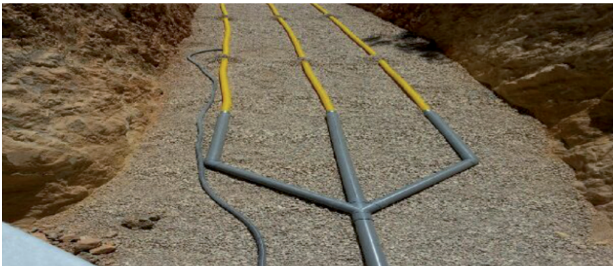
Tubos de drenaje sobre grava en zanjas Tubos de drenagem sobre gravilha em valas
